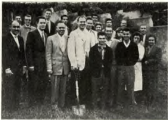
Cerimônia de início de construção com a presença de membros do Comitê Geral de Construção da América do Sul e alguns dos missionários construtores chamados para trabalhar em Pôrto Alegre.
