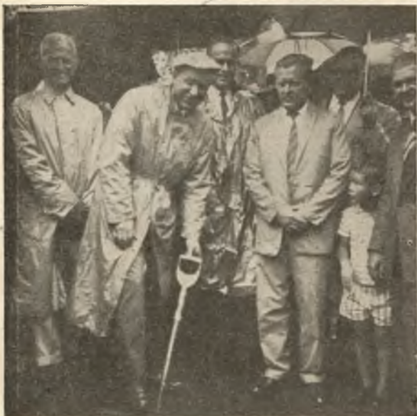
Presidente Tuttle removendo a primeira pá de terra, quando da dedicação do terreno para a construção da capela do Ramo de Santana.
