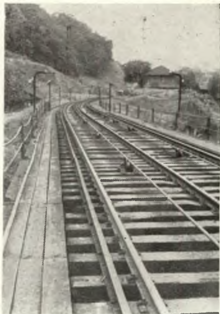
No trecho funicular da "Serra Nova" um cabo prende o vagão-breque.
