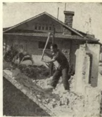
Os construtores chegam e inicia-se a obra com a limpeza do local.
