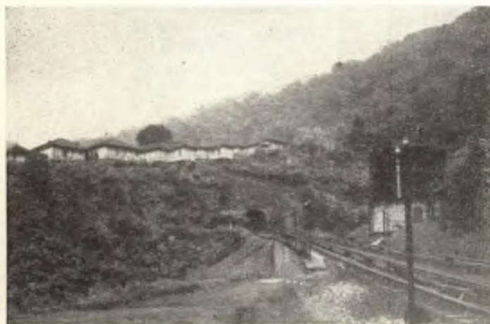
A EFSJ já construiu seu núcleo residencial.
