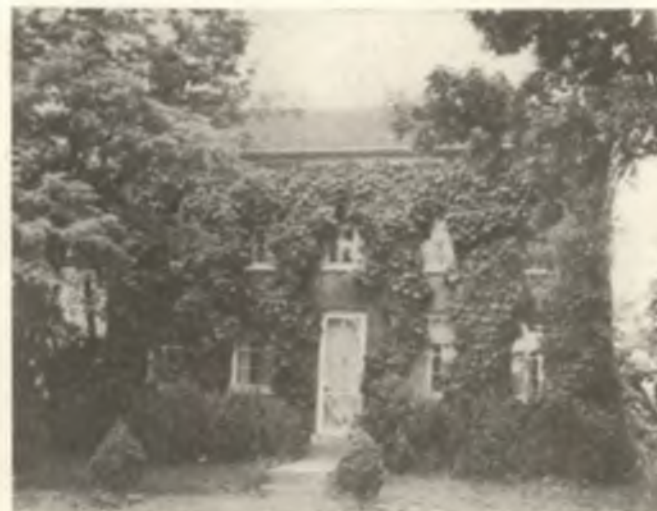
Casa de Willford Woodruff, quarto Presidente da Igreja. Está sendo restaurada e remobiliada.
