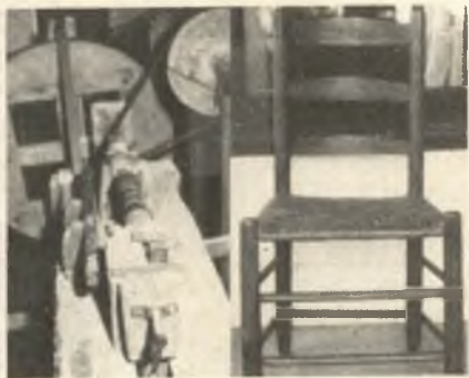
L. À esquerda: O torno que Brigham fez para sua carpintaria, em Mendon, que era movido por roda d'água.
