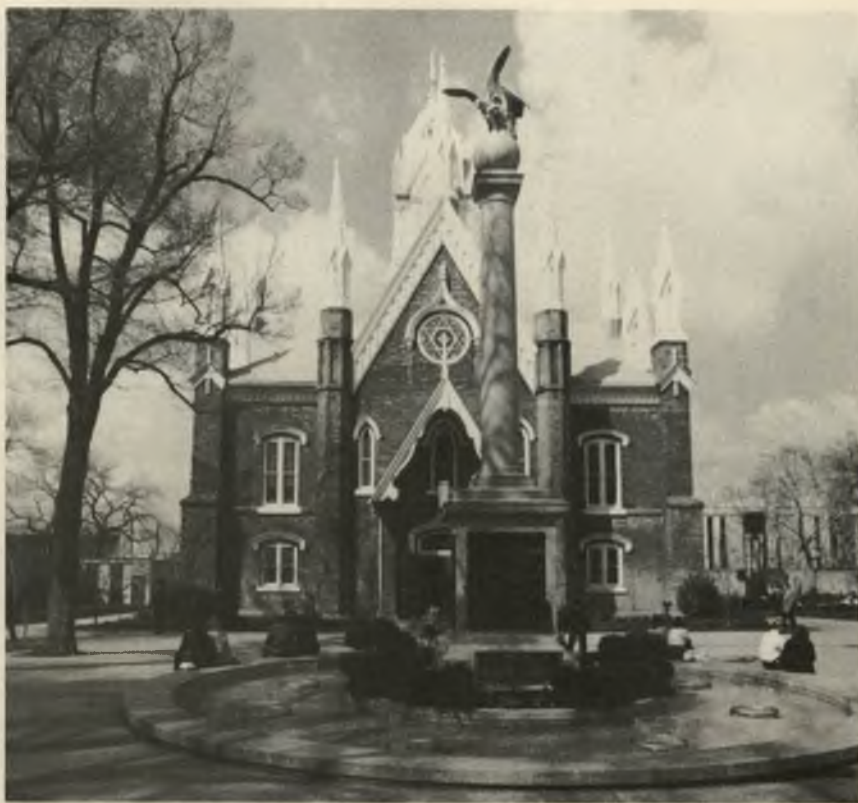
O Assembly Hall, na Praça do Templo.
