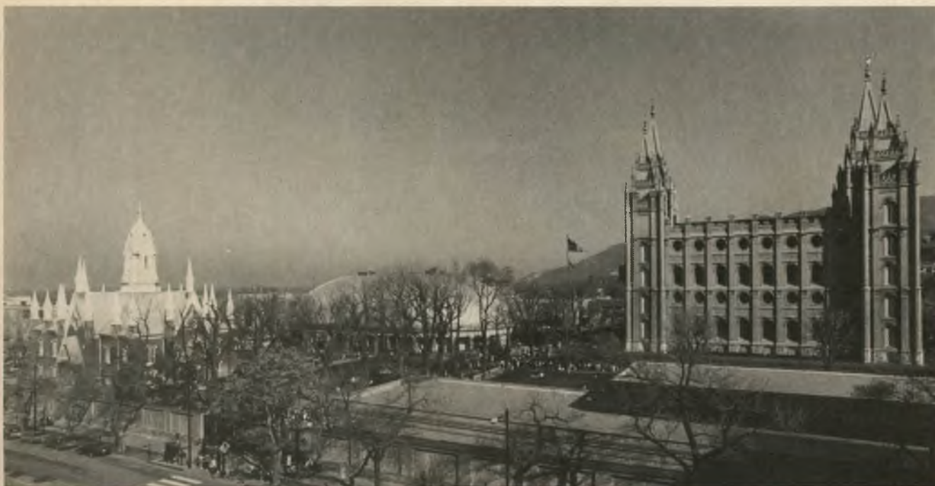
Praça do Templo, na Cidade do Lago Salgado. Edifícios, a começar da esquerda: Assembly Hall, o Tabernáculo e sua cúpula e o Templo de Lago Salgado.
